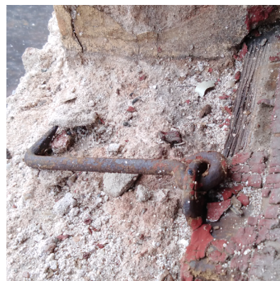
HÁČEK S OČKEM PROTI VĚTRU – DOLNÍ VNĚJŠÍ KŘÍDLO
