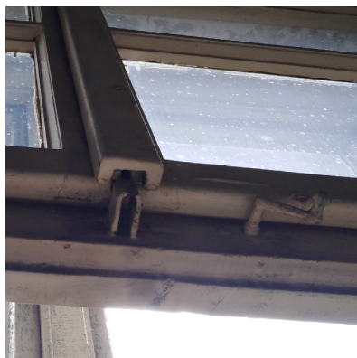
OBRTLÍK PRO ZAJIŠTĚNÍ V UZAVŘENÉ POLOZE – HORNÍ VNITŘNÍ KŘÍDLO
