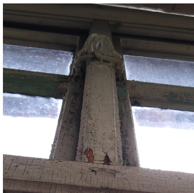
OBRTLÍK VE TVARU OČKA – HORNÍ VNĚJŠÍ KŘÍDLO
