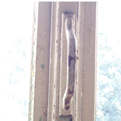
SVISLE POSUVNÉ MADLO – DOLNÍ VNĚJŠÍ KŘÍDLO
